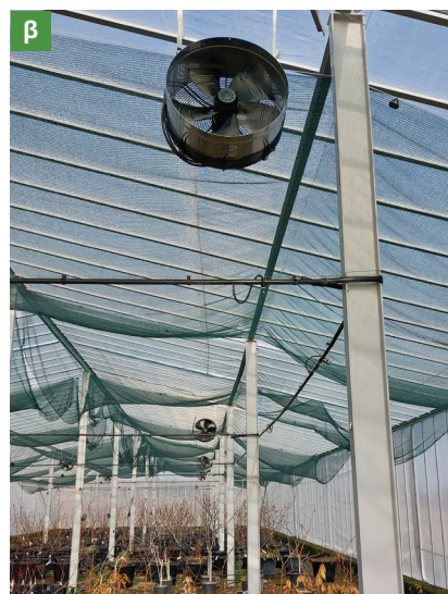
Εικόνα 3. Η τοποθέτηση α) ανεμιστήρων και β) κυκλοφορητών αέρα βοηθούν στο δροσισμό του δικτυοκηπίου.
