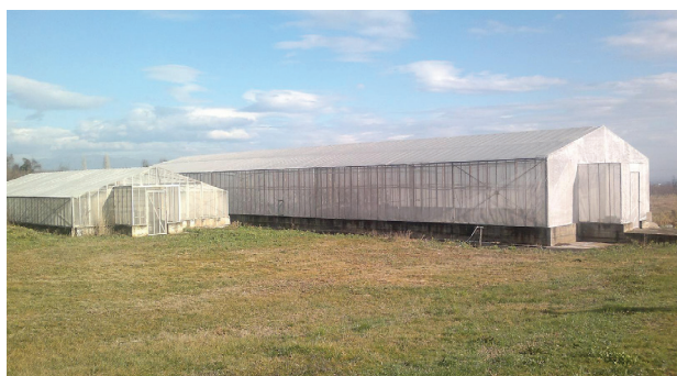
Εικόνα 1. Δικτυοκήπια εγκατεστημένα πάνω σε τσιμέντο στο Τμήμα Φυλλοβόλων Οπωροφόρων Δένδρων Νάουσας
