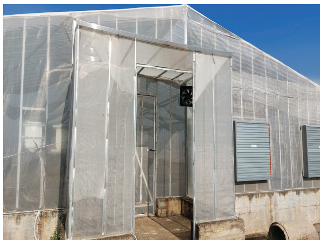
Εικόνα 2. Προθάλαμος στον οποίο βρίσκεται ανεμιστήρας, ο οποίος λειτουργεί με το άνοιγμα της πόρτας και ωθεί τον αέρα προς τα έξω.
