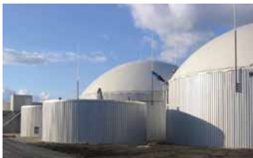
Σχήμα 7.20: Κατακόρυφοι χωνευτές καλυμμένοι από αεροστεγείς μεμβράνες. Η μεμβράνη διογκώνεται από το παραγόμενο βιοαέριο - αριστερά (AGRINZ 2008). Η μεμβράνη είναι στερεωμένη σε έναν κεντρικό ιστό - δεξιά (RUTZ 2006)
