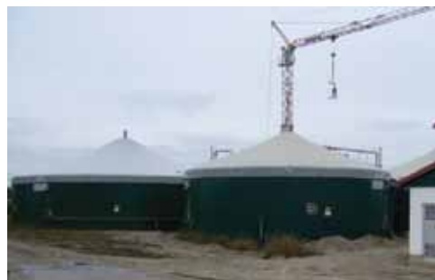
Σχήμα 7.20: Κατακόρυφοι χωνευτές καλυμμένοι από αεροστεγείς μεμβράνες. Η μεμβράνη διογκώνεται από το παραγόμενο βιοαέριο - αριστερά (AGRINZ 2008). Η μεμβράνη είναι στερεωμένη σε έναν κεντρικό ιστό - δεξιά (RUTZ 2006)
