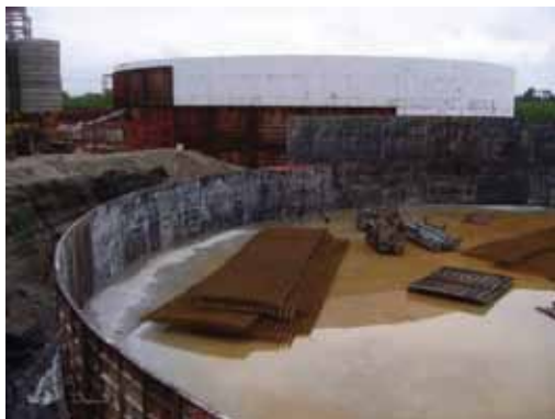
Σχήμα 7.19: Επιτόπου κατασκευή κατακόρυφων χωνευτών από σκυρόδεμα (RUTZ 2007)
