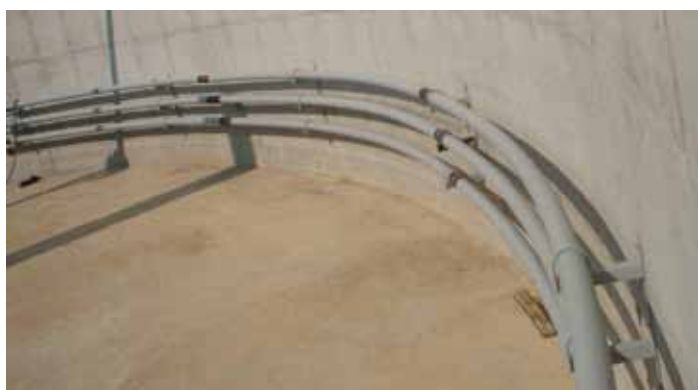
Σχήμα 7.17: Σωληνώσεις θέρμανσης εγκατεστημένες στο χωνευτή (AGRINZ 2008)
