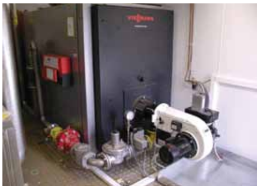
Σχήμα 5.2: Καυστήρας βιοαερίου για παραγωγή θερμότητας (AGRINZ 2008)
