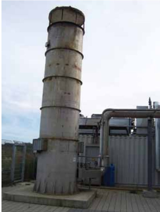
Σχήμα 7.28: Σύγχρονοι πυρσσοί βιοαερίου (RUTZ 2007)
