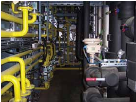
Σχήμα 5.7: Μονάδα συστήματος PSA (αριστερά) και σύνδεση με το δίκτυο φυσικού αερίου (δεξιά) της μονάδας βιομεθανίου στο Pliening, Γερμανία (RUTZ 2007)
