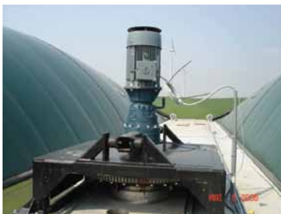
Σχήμα 7.23: Αναδευτήρες κρεμασμένων πτερυγίων (αριστερά) και η αντίστοιχη μηχανή ανάδευσης (δεξιά) (AGRINZ 2006)
