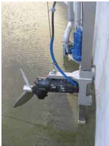
Σχήμα 7.22: Αναδευτήρας έλικας με καταδύόμενο μοτέρ (AGRINZ 2006)
