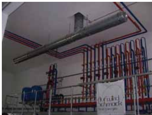
Σχήμα 7.16: Σύστημα θέρμανσης μιας μονάδας βιοαερίου (αριστερά) και μόνωση ενός τσιμεντένιου χωνευτή που είναι υπό κατασκευή (δεξιά) (RUTZ 2008)
