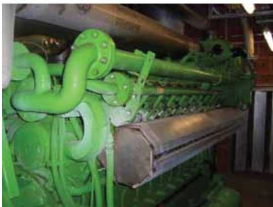
Σχήμα 5.3: Μηχανές αερίου Otto (RUTZ 2007)
