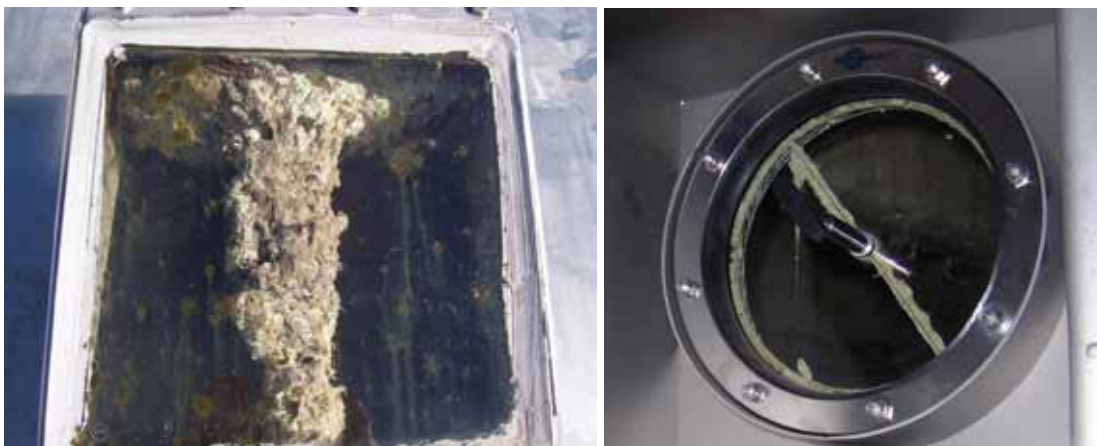
Σχήμα 7.29: Στοιχειακό θείο, που προκύπτει από βιολογική αποθείωση μέσα στο χωνευτή (RUTZ 2007)
